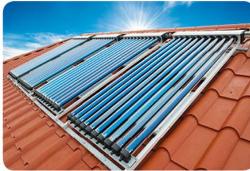
Figura 6.8 Colector solar de tubos de vacío, que aprovecha la energía solar térmica.
