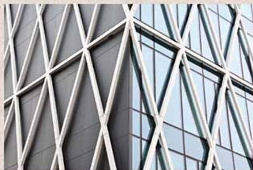
FIGURA 14.14 Edificio reforzado con estructuras metálicas con barras diagonales.
