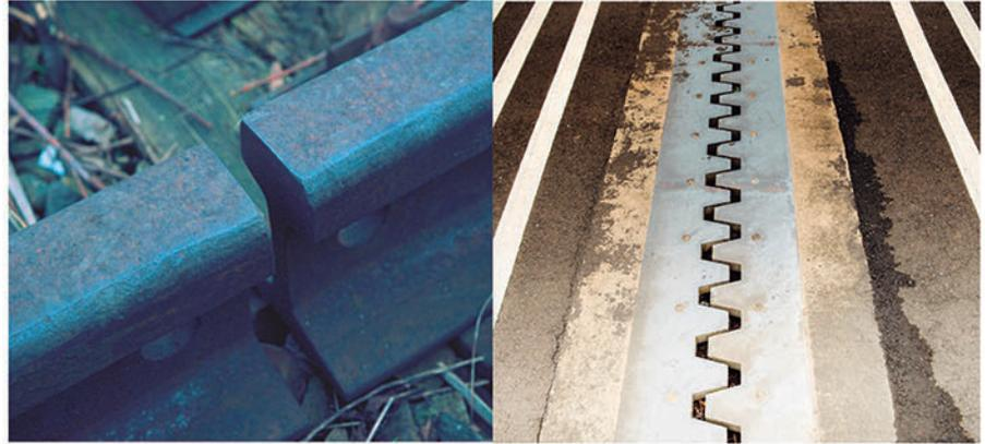
**FIG. 7.11** En las vías y puentes se considera que los metales que forman parte de las estructuras se van a dilatar, por lo que se deja un espacio para que suceda sin causar contratiempos.
