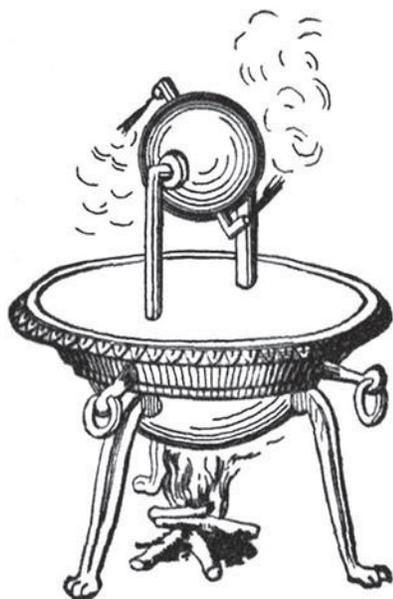
**FIG. 7.3** Eolípilo, aelópilo o aelópila. A pesar de su posibilidad de movimiento con el vapor, jamás tuvo aplicación práctica, solo se usaba como juguete.
