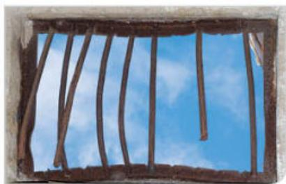
Figura 4.36 Ventana de hierro completamente destruida por la corrosión.
