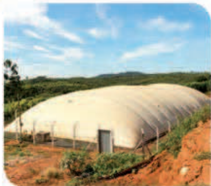
Figura 3.50 Los biodigestores permiten que una pequeña granja obtenga el gas necesario para su funcionamiento.
