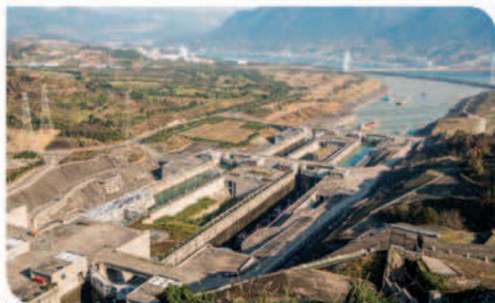
Figura 3.47 La hidroeléctrica Tres gargantas se ubica en la orilla del río Yangtsé.
