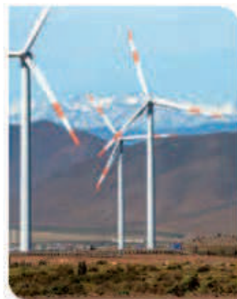
Figura 3.6 Las aspas de los aerogeneradores se pintan con colores vistosos para evitar que las aves choquen con ellas.
