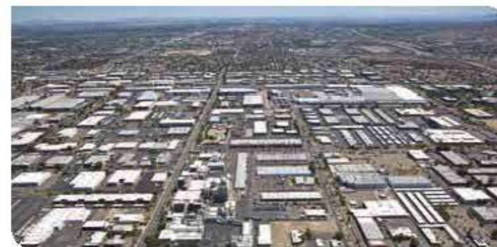
Figura 3.11 Vista aérea de la zona industrial en Tempe, Arizona.
