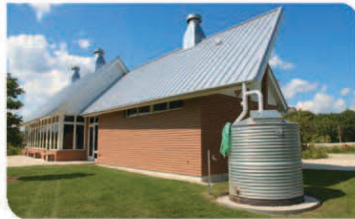
Figura 3.52 Los dispositivos para captar agua de lluvias son muy sencillos y fáciles de instalar.
